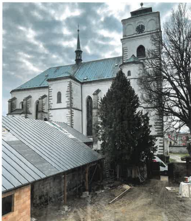
Stavba nové knihovny, pohled na zahradu Šrámkova domu.
